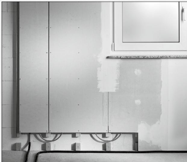
Sistem zidnog grejanja za suvu unutrašnju izgradnju kod renoviranja i u novogradnjama. Cevi od polibutilena 12 x 1,3 mm su već integrirane u zidnu ploču za grejanje, tako da nisu potrebni nikakvi dodatni radovi sa masom za ispunu. Montaža se vrši na podkonstrukciju odnosno direktno na metalne nosače kod suvih zidova.
