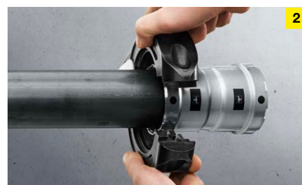
Na zlisovanie spojok Megapress od 1¼ cól sa používajú výlučne lisovacie prstence s kĺbovými čelustami. V menších rozmeroch medzi ¾ a 1 cólom sú na výber tak lisovacie čeluste, ako aj lisovacie prstence s kĺbovými čelustami.
