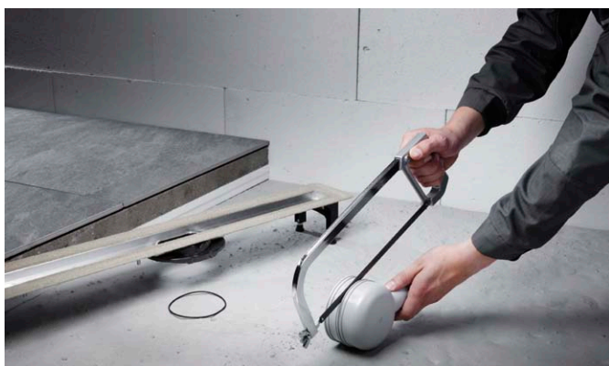
Vďaka jednoduchému odrezaniu sa dá štandardný odtok ešte priamo na mieste premeniť na sanačný model.
