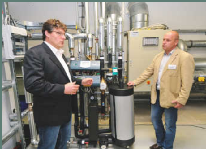
Solvis-Vertriebsleiter Dipl.-Ing. Karsten Woelk (li.) und HLF-Techniker Andre Stagge erläutern den ganzheitlichen, energetischen und trinkwasserhygienischen Ansatz der neuen Trinkwasseranlage, die vom Erwärmungssystem „SolvisVital“ gespeist wird.
