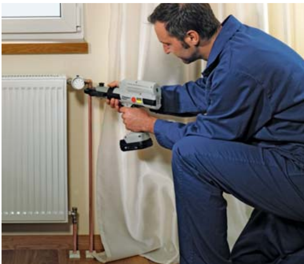
Delo brez sledu: Z Viega orodji za hladno stiskanje boste brez težav dosegli nedostopna mesta in nikjer ne boste pustili sledi o delu.
