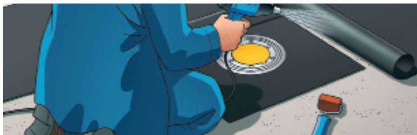
3–21 pav. EPDM sandarinimo juostos prilydymas karštu oru
