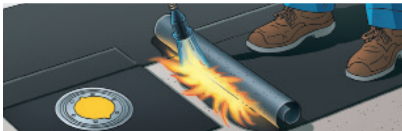
3–20 pav. Bituminių sandarinimo juostų prilydymas dujų degikliu
