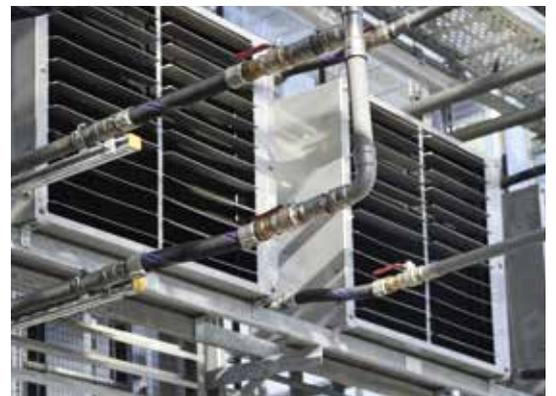
Flexibel, um die Bewegungen durch thermische und mechanische Einflüsse auszugleichen: die Anbindung der Heizregister und der Anschluss an die Hauptverteilung.
