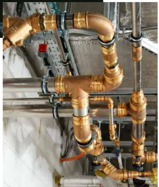
**Für die Hauptverteilung des Trinkwassers wurden insgesamt acht Kilometer des Edelstahl-Rohrleitungssystems Sanpress installiert.**
