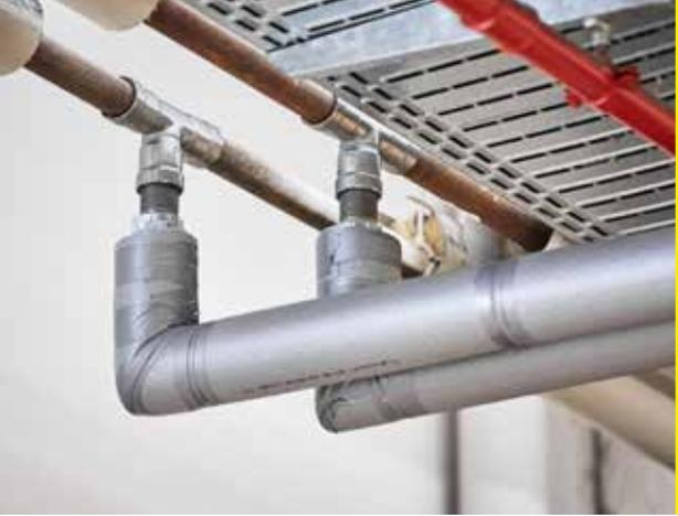
Sekundenschnell verpresst statt zeitaufwendig geschweißt: Megapress-Abgänge in der Produktionshalle.
