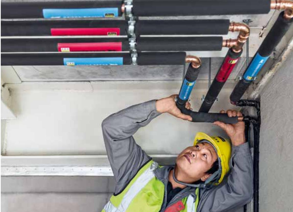
In den Gebäuden wurden über 100.000 m Kupferrohrleitungen des Typs Viega Profipress verbaut.
