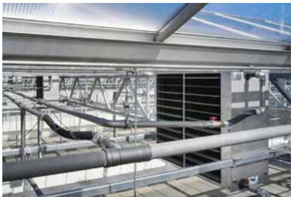
Die enorme Festigkeit der Stahlrohre und der Megapress-Verbinder erlauben unter den Hallendecken eine Verrohrung mit einem Minimum an Festpunkten.
