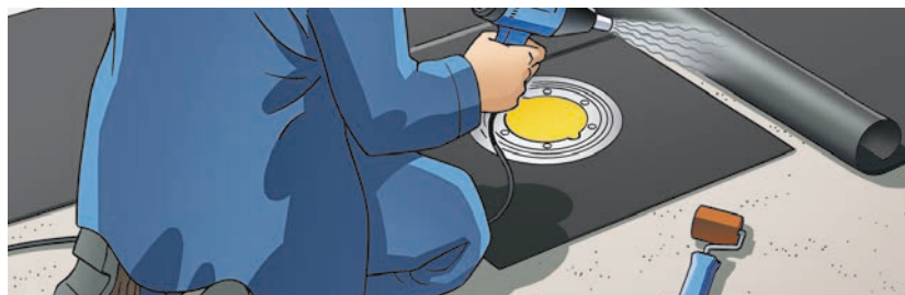
Fig. 3 – 21 Lipirea benzii de etanșare EPDM cu aer fierbinte
