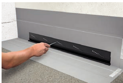
Fig. 3 - 31 Scurgere de perete - flanșă de etanșare
