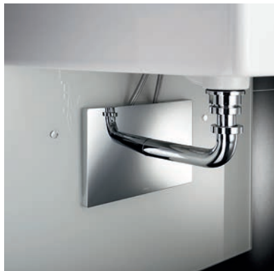
Fig. 2 – 78 Instalarea cutiei de racordare sub tencuială Viega
