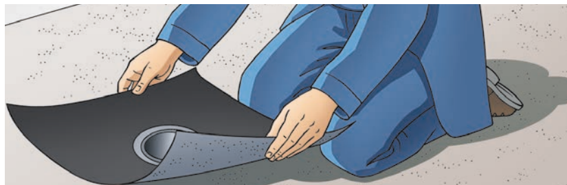
Fig. 3 – 19 Așezarea manșetei pentru hidroizolare
